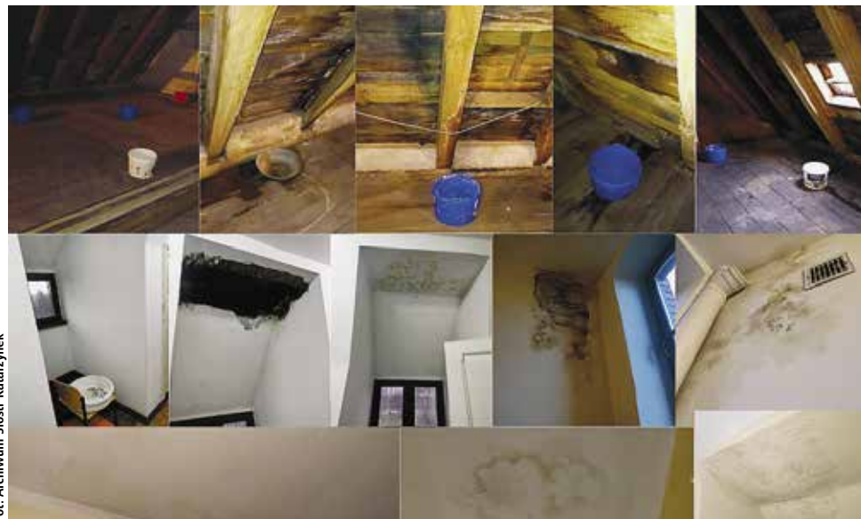
Podstawianie wiader tam, gdzie cieknie woda, to tylko rozwiązania doraźne. Dach klasztoru potrzebuje gruntownego remontu
